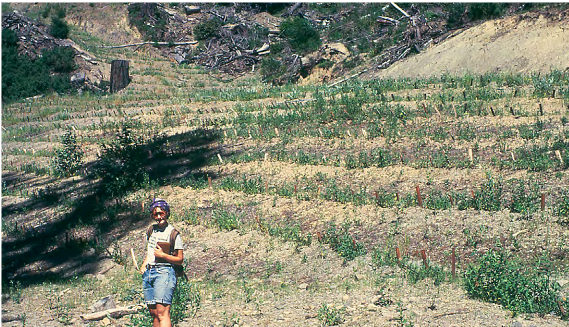
FIGURE 189. Live fascines (Holanda and Pinheiro da Rocha, 2011)
